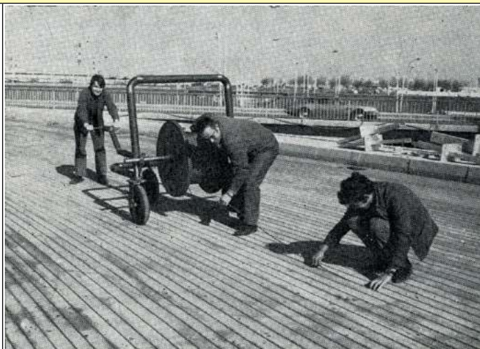
1968 Установка нагревательного полотна на подъездном пандусе к платформе для стоянки автобусов, аэропорт Орли под Парижем (Электрический теплый пол, автор Робер Феликс, 1971 г., Музей Ultimheat*)
